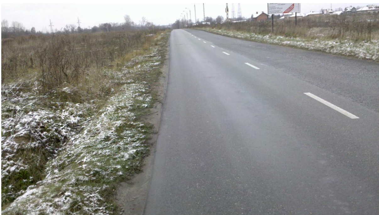
Fot. Widok z góry jezdni od strony północnej.
