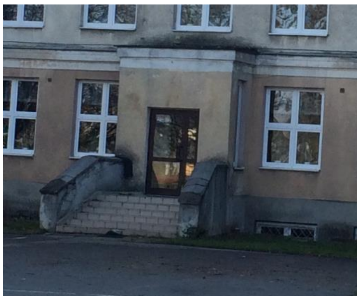
Rys. 10. Widok schodów istniejących
