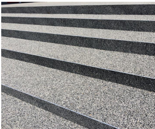
Rys. 11. Przykładowy wygląd schodów po remoncie i oblicowaniu
