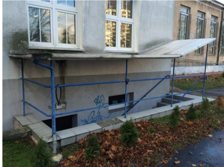
Rys. 5. Widok istniejącego zadaszenia nad wejściem do siłowni
